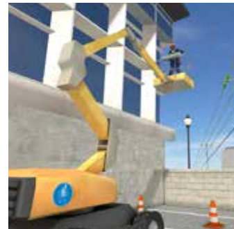
Travaux en hauteur
